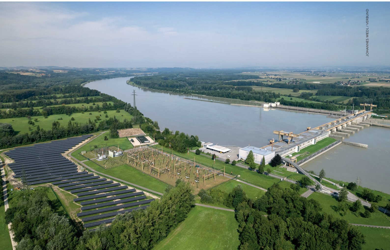
Wallsee-Mitterkirchen Photovoltaik am Kraftwerksstandort.
